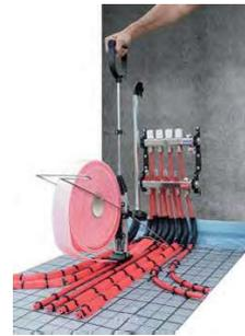
Anwendung: Tackergerät R2 mit Abrollvorrichtung für FBH Dämmstreifen
