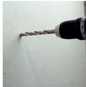
Ø 10 mm Loch in Rückseite bohren
