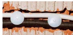
Befestigung von Leitungen und Rohren unterschiedlicher Größen im Unterputzbereich
